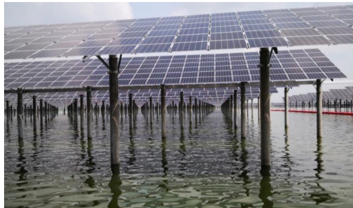
图 2-5 光伏阵列安装实景照片
